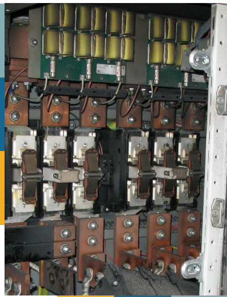
Roet in hoogspanningsinstallaties kan vlambogen veroorzaken omdat het roet geleidend is.
