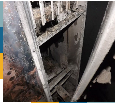
Een boogflits is een krachtige energieafgifte. Zelfs metalen kunnen bij hoge temperaturen smelten en verdampen.
